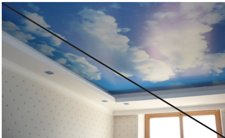
Плохо Натяжные потолки. Потолки с рисунками
